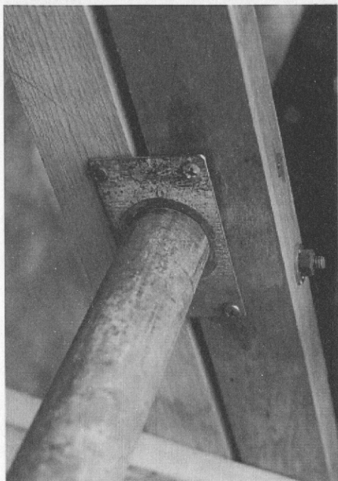
Beschlag fürs Mastlager ↗ Bremsseil-Führung. Regenschutz ohne ↗ und mit ↘ Bezug.
